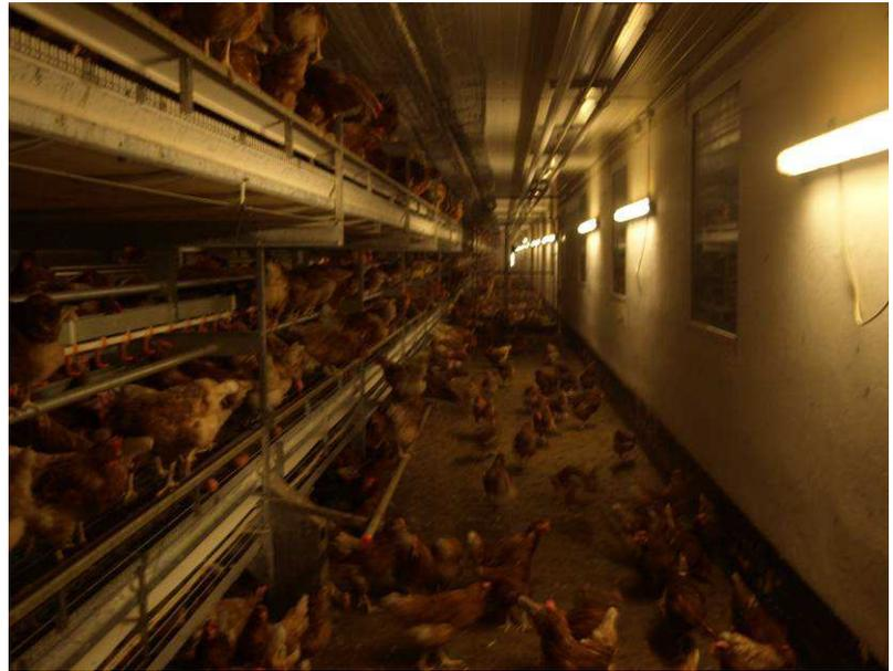
**Abb. 2: Künstliche Beleuchtung mit hochfrequenten Leuchtstoffröhren**
