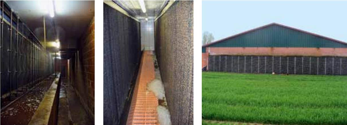
Abb. 4a–c: Beispiel für eine mehrstufige Abluftreinigungsanlage mit Rohgaseintritt in den Vorraum (links), zwei Füllkörperwänden (Mitte) und Biofilter als finale Reinigungsstufe (rechts)
