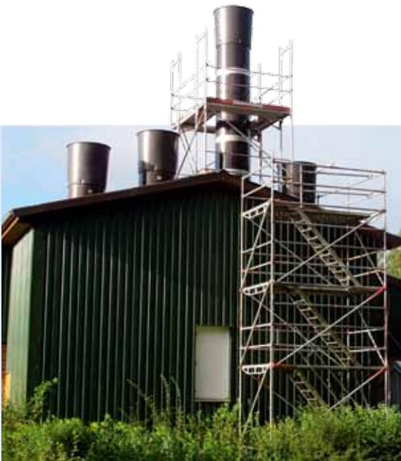
Auf dem Markt sind außerdem eine Reihe mehrstufiger Techniken verfügbar, die die Vorteile der Abluftwäsche (gute Ammoniakabscheidung) mit denen der Biofilter (guter Geruchsstoffabbau) verbinden (Abb. 4).
