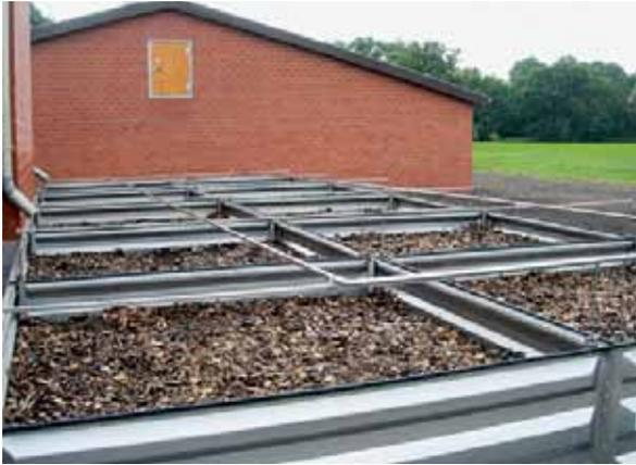
Abb. 2: Blick auf einen einstufigen Biofilter zur Reinigung von Abluft aus Schweinehaltungen
