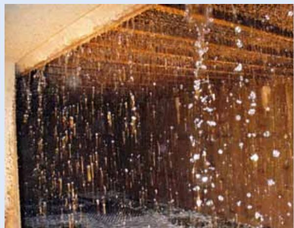
Abb. 3a und b: Blick auf einen Rieselbettfilter (links) und auf den Bereich des Rohlufteintritts in die Abluftreinigungsanlage (rechts)
