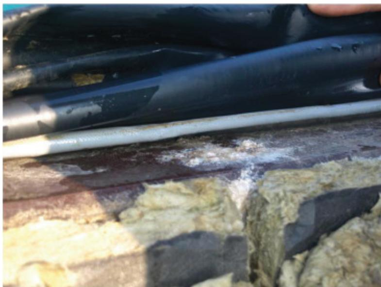
**Abbildung 8: Undichter Behälterrand mit Schwefelablagerungen (Kohne 2010)**
