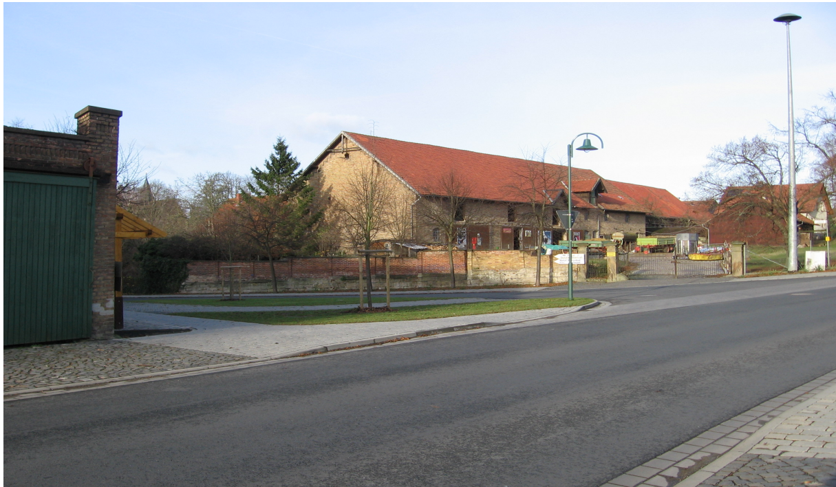
Abbildung 16.51: Neu gestaltete Dorfstraße in Steinlah
