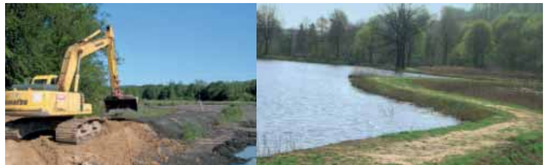
Gut sieben Monate dauerten die umfangreichen Sanierungsmaßnahmen an den fünf unter Naturschutz stehenden Walkenrieder Klosterteichen.
