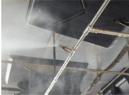
Abb. 18 und 19: Hochdruckvernebelungsanlagen erzeugen Tröpfchengrößen von 2 bis 10  $\mu\text{m}$  und erzielen eine schnelle und effektive Kühlung. Die Düsen können sowohl im Abteil als auch im Zuluftbereich montiert sein. Zu beachten ist, dass die Luftfeuchtigkeit im Abteil nicht zu stark ansteigen darf (Fotos: Katrin Peperkorn, LWK Niedersachsen).
