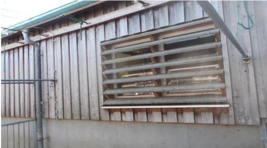
Abb. 16: Direkte Sonneneinstrahlung führt zu zusätzlicher Wärmebelastung und kann bei den Tieren Unruhe und Stress auslösen. Mit Hilfe von Lamellen vor den Fenstern kann die Sonneneinstrahlung verringert werden (Foto: Löwenstein, LSZ Boxberg).
