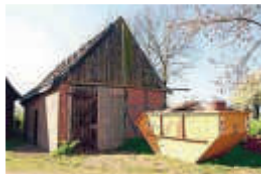
Diese Scheune im Schlüsselburger Scheunenviertel wird saniert und umgebaut. Entstehen wird für die Besucher eine Informationsscheune mit Sanitäreinrichtung.
