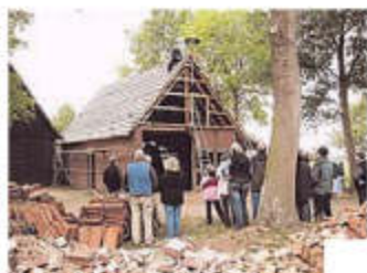
Die Arbeiten an der zukünftigen Informationsscheune in Schlüsselburg machen Fortschritte. Das Dach des Spitzdachgebäudes zielt ein Richtkranz. | Foto: Ulrich Westermann
