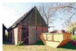
Diese Scheune im Schlüsselburger Scheunenviertel wird saniert und umgebaut. Entbrenn wird für die Besucher eine Informationsscheune mit Sanitäranlage.
