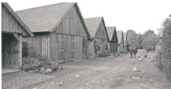
Ungenutzte Scheunen im Scheunenviertel Ahlden
