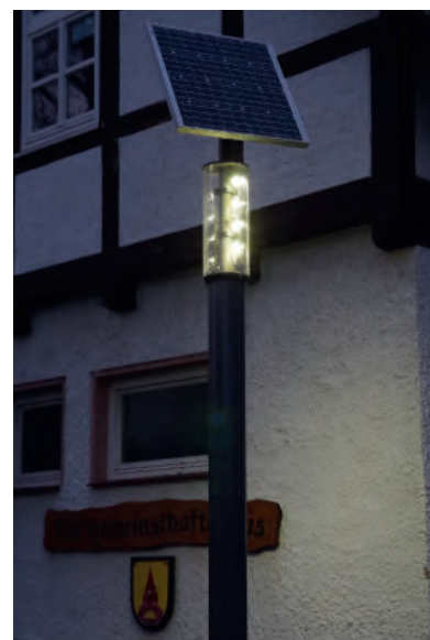
Selbstregelnde LED-Solar-Leuchten an einem Dorfplatz
