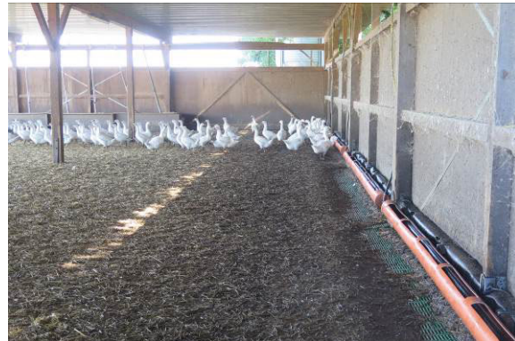
Unter den Tränkerohren ist ein Ablauf vorgesehen.
