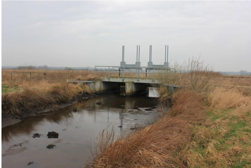
Foto 9: Auslassbauwerk am Retentionsraum 3, Sootgruppen
