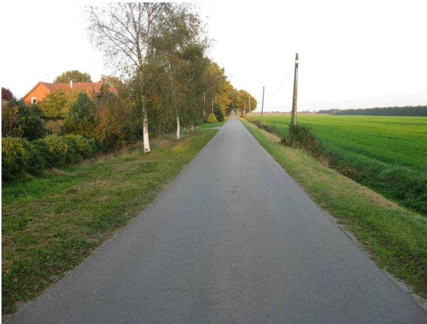
Foto 15: Ausgebauter Weg im Bereich Ostermoor
