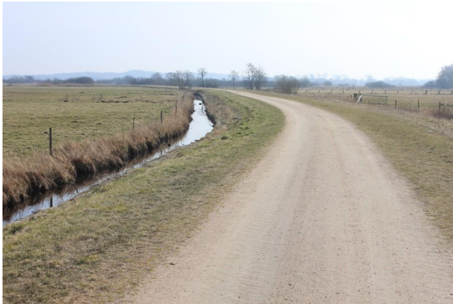
Foto 10: Weg in Schotterbauweise mit „sandgelber“ Deckschicht zwischen Teufelsmoor und Neu-Helgoland (Verfahrensgebiet Hammeniederung II)
