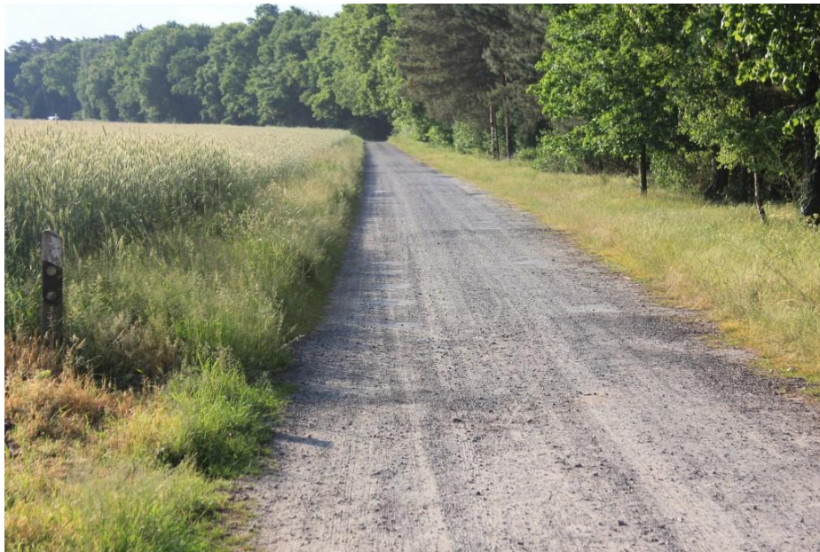
Foto 22: Weg in Schotterbauweise
