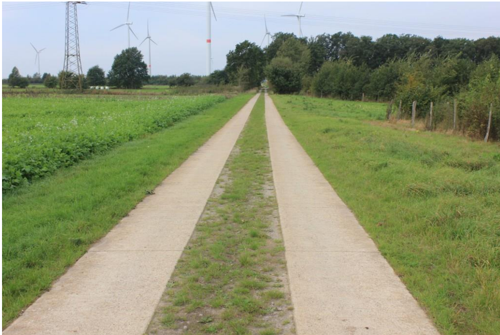
Foto 18: Auf alter Trasse neu ausgebaute Beton-Spurbahn
