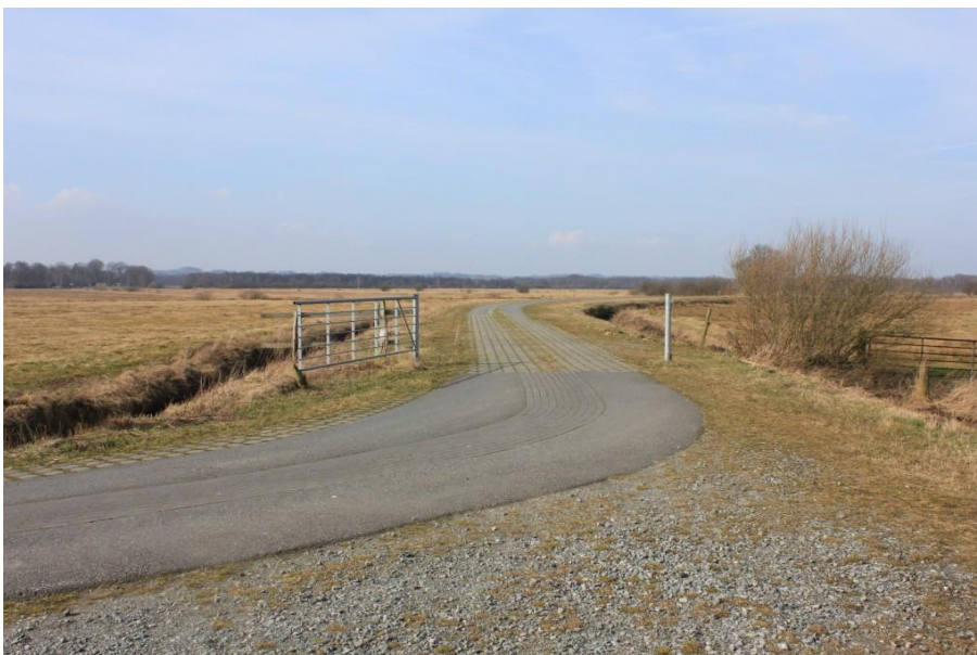
Foto 12: Spurbahn mit verschließbarem Weidetor im Verfahrensgebiet Hammeniederung I
