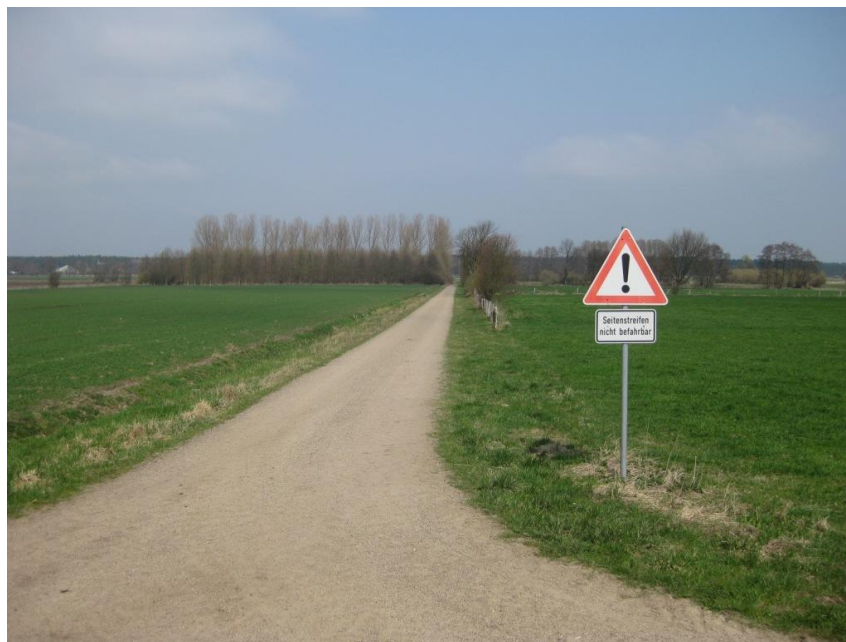
Foto 2: Leichte Befestigung eines Weges mit Mineralgemisch
