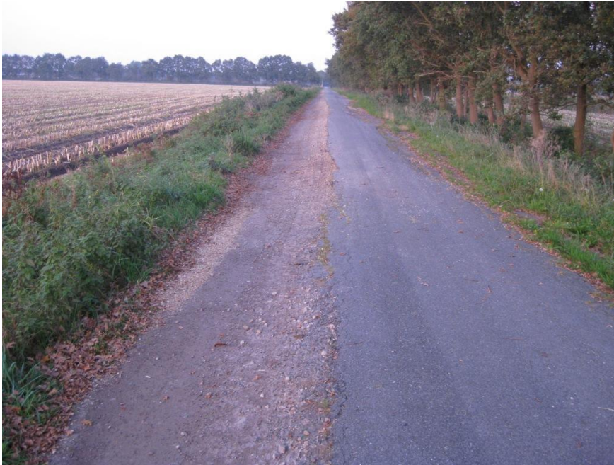
Foto 14: Typisches Schadbild an Schwarzdecken
