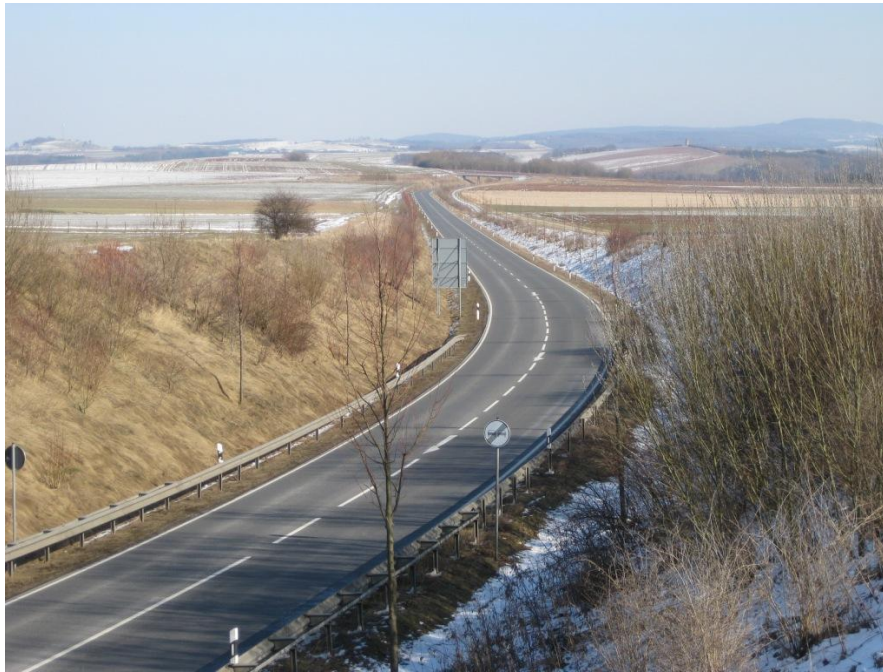
Foto 4: Die Umgehungsstraße B446 zwischen Esplingerode und Desingerode
