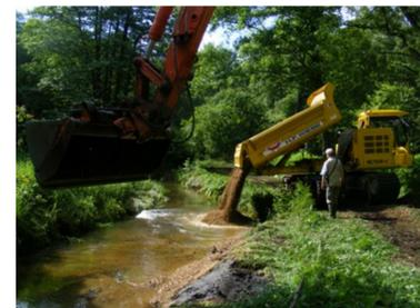
Foto 1: Kiestransport und Kieseinbau mit einem Drehkranz-Ketten-Dumper im Einzugsgebiet der Lachte (Foto: J. Kubitzki)
