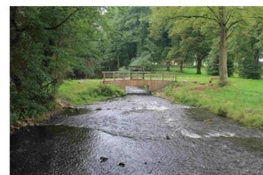
Foto 2: Sohlgleite in Riegelbauweise mit erneuerten Fußgängerbrücke an der ehemaligen Dorfschleuse in Fischerhude (Foto: M. Bathke)
